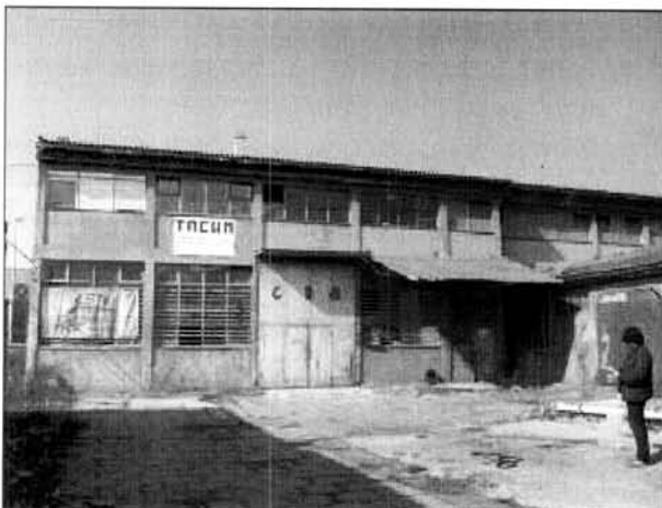
Објект 1а - Изглед
