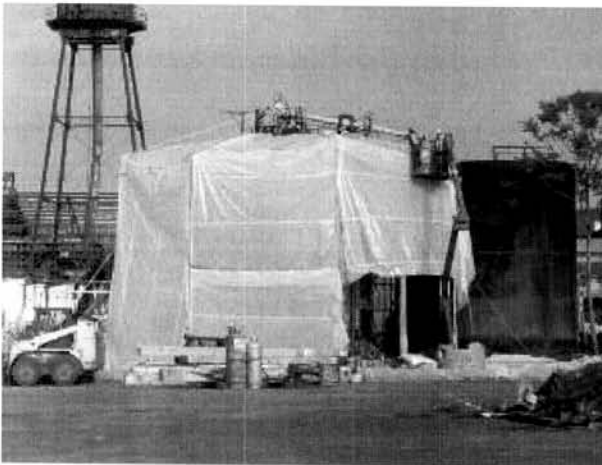
Припрема за уклањање материјала на бази азбеста
